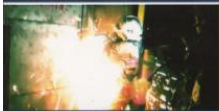
сварочные работы, окурки
